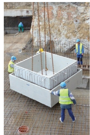
105. Előregyártott négyszögletes vasbeton akna telepítése
