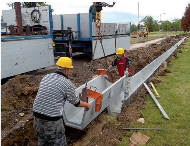
26. Árokburkoló elemek beépítése
