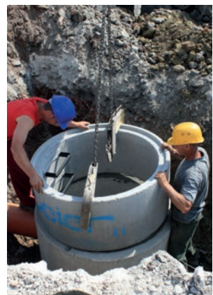
115. Cementhabarcsos csatlakozás kialakítása
