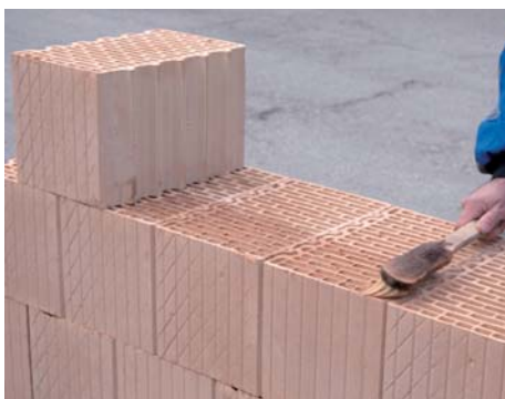
13. LeierPLAN falazóelem előnedvesítése ragasztás előtt
