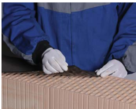
18. Falszerkezet lezárása bitumenes szigetelőlemezzel
