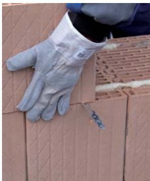
20. Falazóelem elhelyezése bekötőszalagos csatlakozásnál
