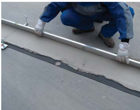
8. Kezdősor alatti habarcssáv kialakítása
