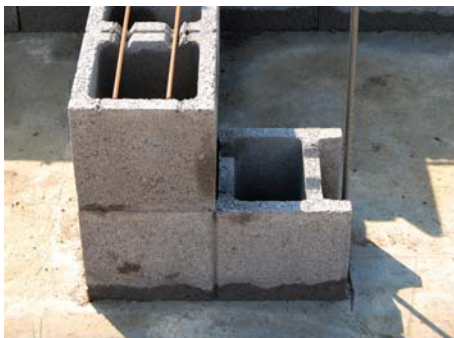
5. Falsarok kialakítása
