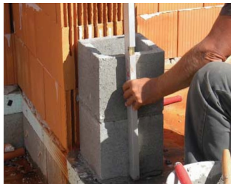
10. A függőleges ellenőrzése
