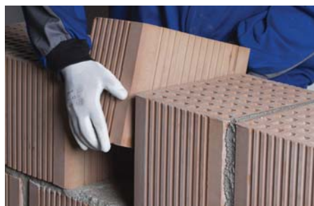
37. Vágott elem elhelyezése hanggátló falba (25/30 AKU)
