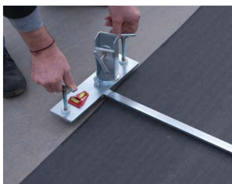
6. Szint beállítása a nivelláló készleten
