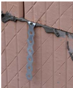
21. Lehajtott helyzetű bekötőszalag
