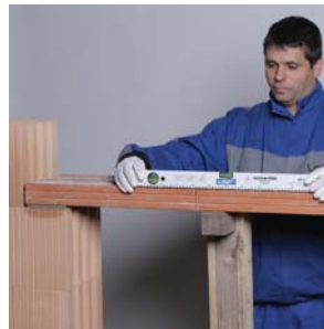
49. Vízszintes helyzet ellenőrzése
