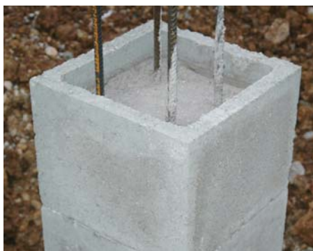
12. Kibetonozott pillérzsaluzó elem
