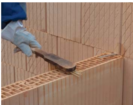
23. LeierPLAN válaszfalelem előnedvesítése
