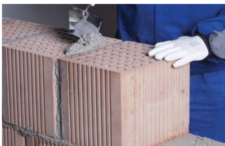
36. Hanggátló fal függőleges habarcshezag (25/30 AKU)
