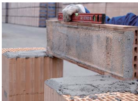
43. Felfekvési felület LeierPLAN falszerkezet esetén
