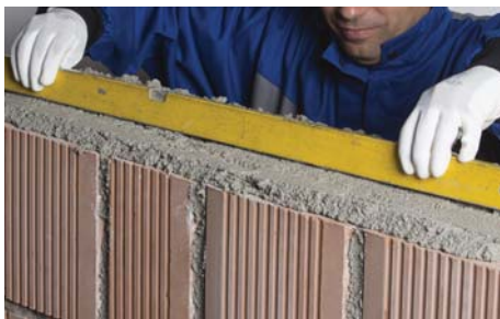
38. Hanggátló fal építése: falegyen képzés (25/30 AKU)
