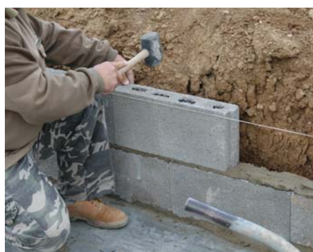
4. Válaszfalelem beállítása
