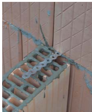
22. Válaszfalelemre hajtott bekötőszalag
