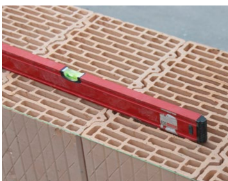
17. Faltest ellenőrzése vízmértékkel
