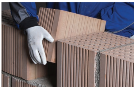
37. Vágott elem elhelyezése hanggátló falba (25/30 AKU)
