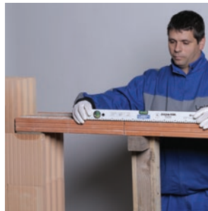
49. Vízszintes helyzet ellenőrzése
