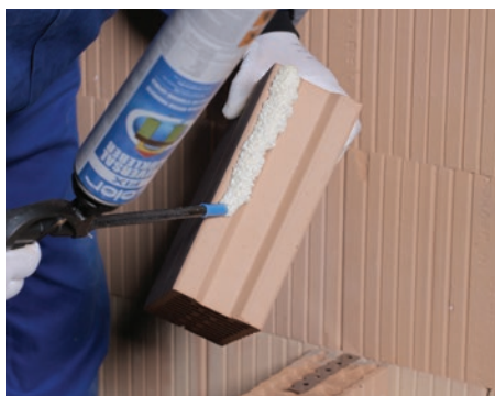
26. Ragasztó felhordása az elem függőleges felületére falcsatlakozásnál
