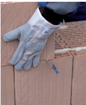
20. Falazóelem elhelyezése bekötőszalagos csatlakozásnál
