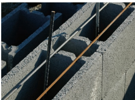
7. Függőleges és vízszintes vasalás betonzás előtt
