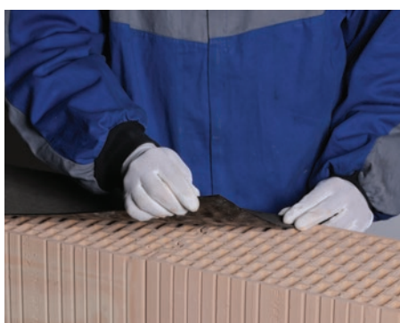
18. Falszerkezet lezárása bitumenes szigetelőlemezzel
