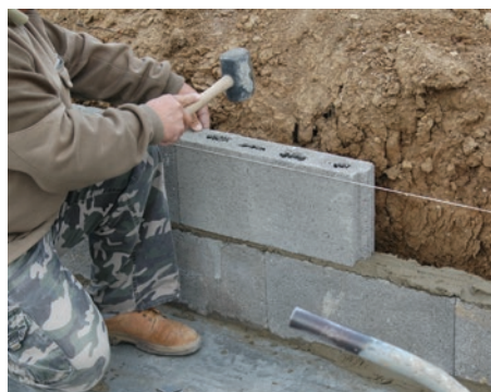
4. Válaszfalelem beállítása
