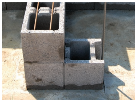
5. Falsarok kialakítása
