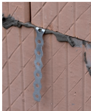
21. Lehajtott helyzetű bekötőszalag
