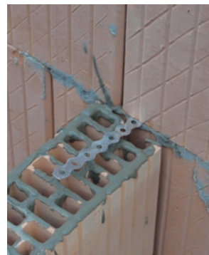
22. Válaszfalelemre hajtott bekötőszalag
