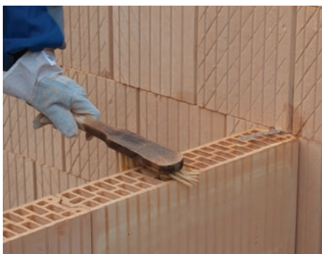
23. LeierPLAN válaszfalelem előnedvesítése
