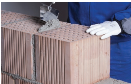
36. Hanggátló fal függőleges habarcshezag (25/30 AKU)
