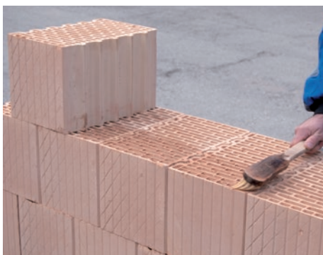
13. LeierPLAN falazóelem előnedvesítése ragasztás előtt
