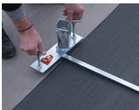
6. Szint beállítása a nivelláló készleten
