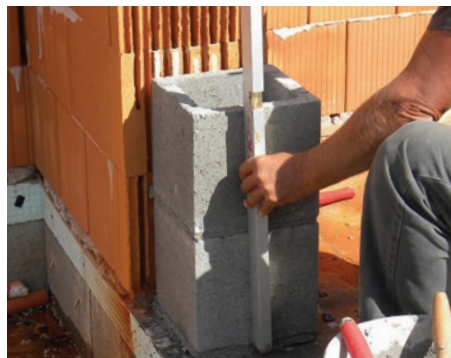
10. A függőleges ellenőrzése
