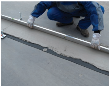
8. Kezdősor alatti habarcssáv kialakítása
