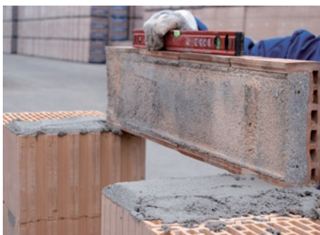
43. Felfekvésí felület LeierPLAN falszerkezet esetén
