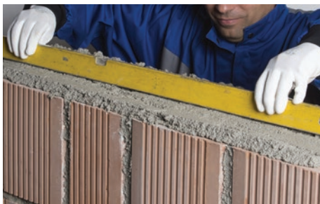
38. Hanggátló fal építése: falegyen képzés (25/30 AKU)
