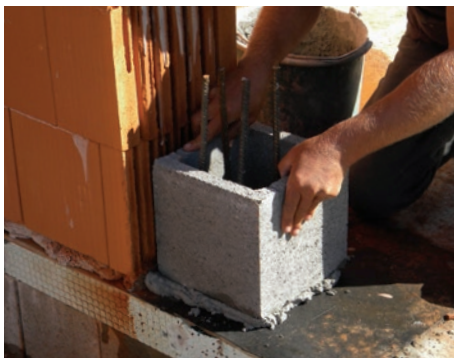
9. Első pillérzsaluzó elem elhelyezése
