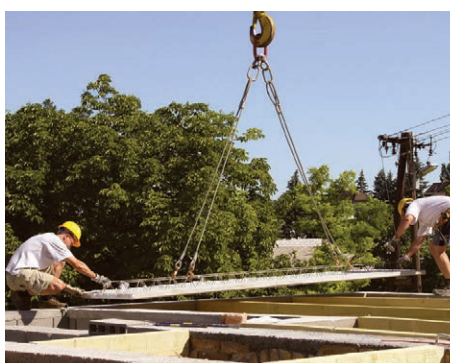
21. Leier mesterpanel (LMP) végleges elhelyezése
