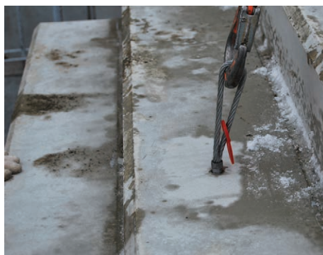
7. Előre elhelyezett függesztőelemek (dűbelek)
