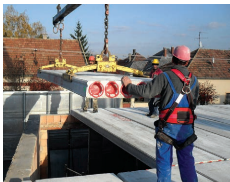
12. Födémpanel óvatos beemelése
