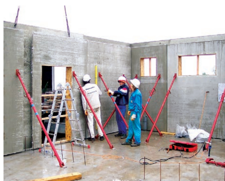
40. Leier kéregfal (LKF) pontos beállítása, ellenőrzése
