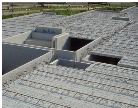
8. Födémáttörés tervezett helyeken
