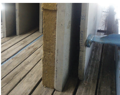
3. Leier kéregfal külső oldali hőszigeteléssel
