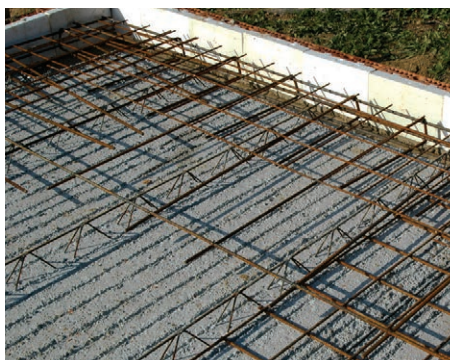
25. Koszorú kialakítása a födémşélen
