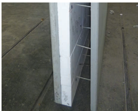
2. Leier kéregfal belső oldali hőszigeteléssel (LKF-S)
