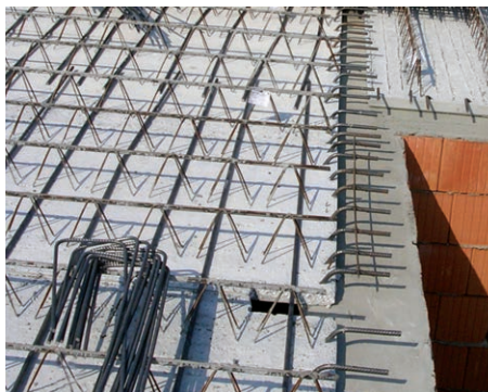
23. Két irányban teherhordó lemez keresztirányú vasalása Leier mesterpanelen (LMP)
