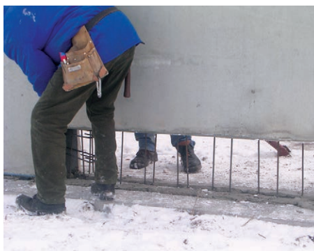
42. Leier kéregfal (LKF) óvatos beemelése már beállított elem mellé
