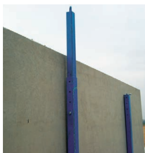
22. Állítható magasságú támasztóoszlop
