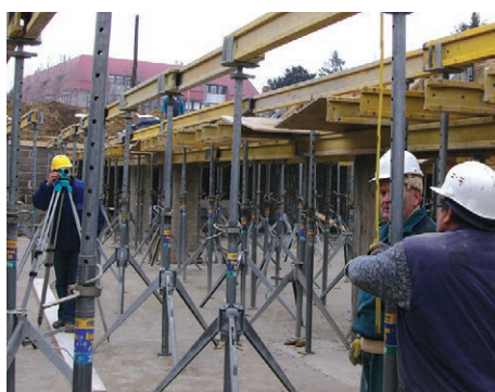
17. Alátámasztó állvány pontos beállítása, ellenőrzése
