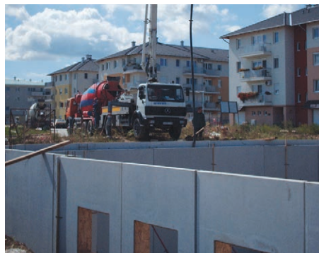
44. Leier kéregfal (LKF) kibetonozása
