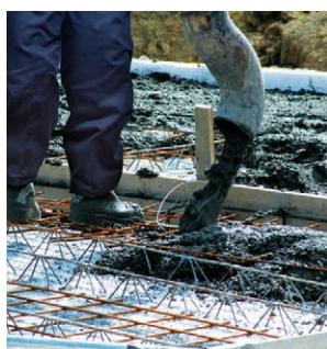
28. Betonozás betonpumpával
