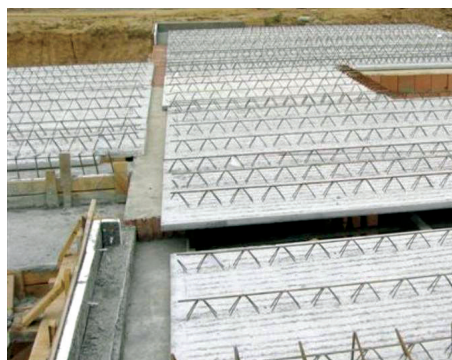
7. Falegyenre fektetett Leier mesterpanel (LMP)
