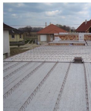
1. Leier mesterpanel (LMP) beépítve
