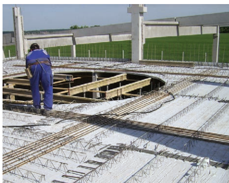
9. Födémáttörés mentén elhelyezett pótvasalás
