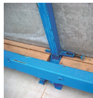
25. Támasztóoszlop rögzítése
