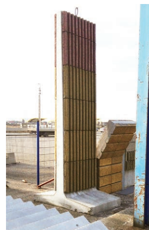
7. Durisol borítású mobil elválasztó falelem
