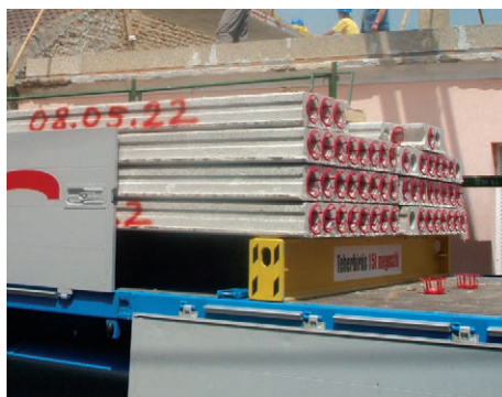
10. Leier üreges födémpanelló szállítása (max. 4 sor)
