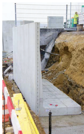
4. Szerelőbetonra emelt, beállított Leier támfal
