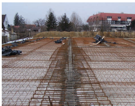
24. Födémátkötő vas középfőfal felett
