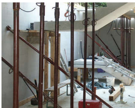
6. Külön elemekből álló Leier lépcső alátámasztása
