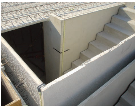
9. Építési rendszer: Leier kéregfal (LKF) – Leier mesterpanel (LMP) – Leier lépcső
