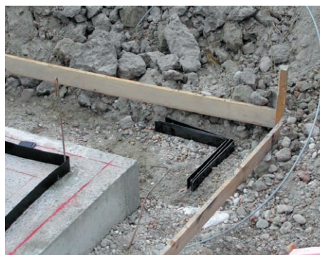
36. Falsarkokhoz készített acélpántok a sarkok biztosításához
