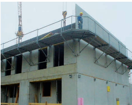
43. Munkaállvány betonozáshoz
