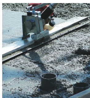
30. Helyszíni felbeton tömörítése, simítása
