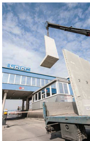
3. Támfal emelése szállítójárműről
