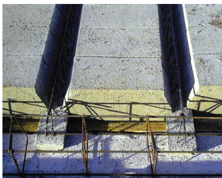
21. Koszorú melletti lezáró béléstestek
