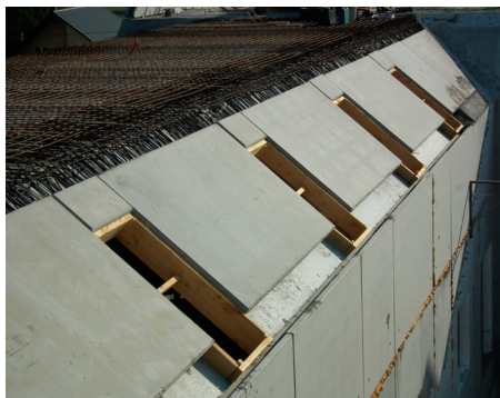
10. Leier kéregfal (LKF) alkalmazása koporsófödémként
