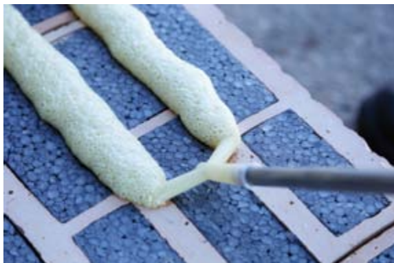
Leier PLAN 44 ISO+ ragasztóhabos kötése.
