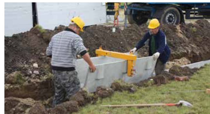
a speciális emelőszerszögeknek köszönhetően, rendkívül hatékony az elemek beépítése
