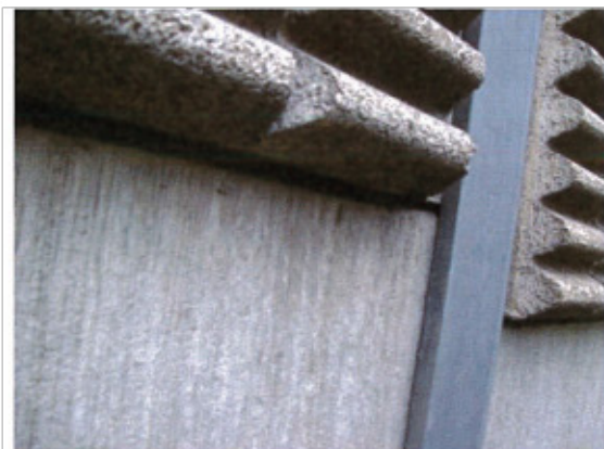
6. ábra: Részlet: zárt illesztő hézag a betonhoz
